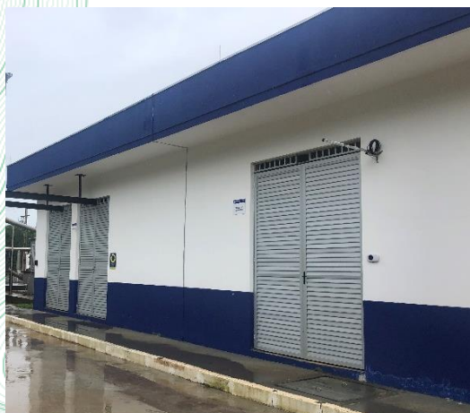
Figura 27 - Vista do prédio de controle do sistema de tratamento da ETE
