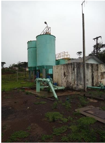
Figura 19 - Visão da ETA de Turvo-PR
