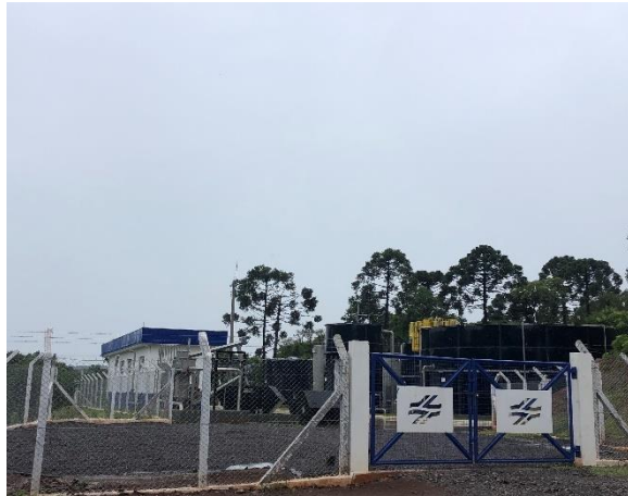
Figura 23 - Visão da entrada da ETE de Turvo-PR
