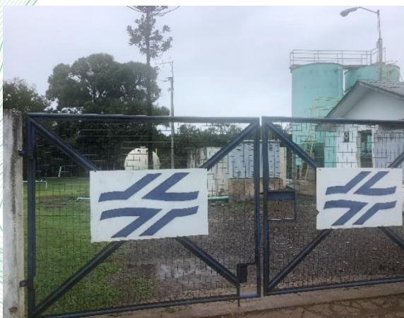
Figura 15 - Entrada da Estação de Tratamento de Água de Turvo-PR
